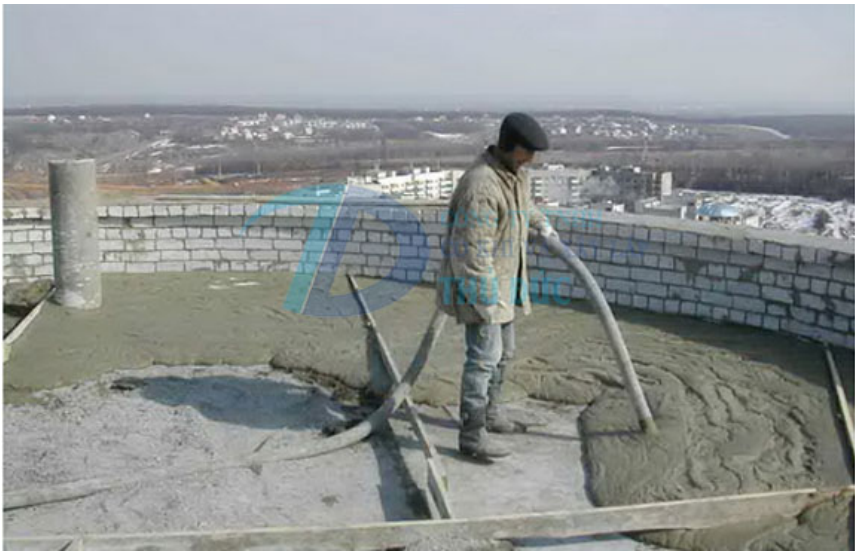
Bê tông nhẹ đổ sàn cách nhiệt, chống nóng:
